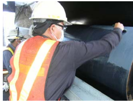
ทากาว Cement SC 2000 ที่ยางหุ้มและผิว Pulley อย่างละ 2 รอบ
