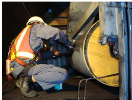
ทากาว Cement SC 2000 ที่ยางหุ้มและผิว Pulley อย่างละ 2 รอบ
