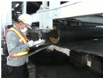
ทำการตรวจสอบความเรียบร้อยของงาน หลังการหุ้มยาง
