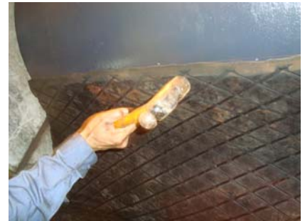
นำแผ่นยางมาหุ้ม Pulley และใช้ฉนวนยางทูปไล่อากาศให้ทั่ว ชัดแต่งรอยต่อของยางให้เรียบร้อย
