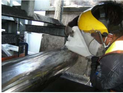
ขัดผิว ทำความสะอาดด้วยน้ำยา Trichloroethylene
