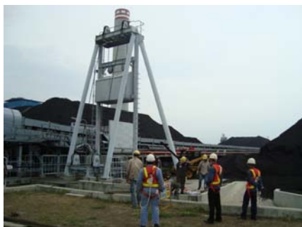
ยกถังถ่วงขึ้นเพื่อถ่างสายพานให้มีพื้นที่หุ้ม Pulley ได้สะดวก
