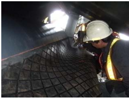
นำแผ่นยางมาหุ้ม Pulley และใช้ฉนวนยางทาบไล่อากาศให้ทั่ว ขัดแต่งรอยต่อของยางให้
