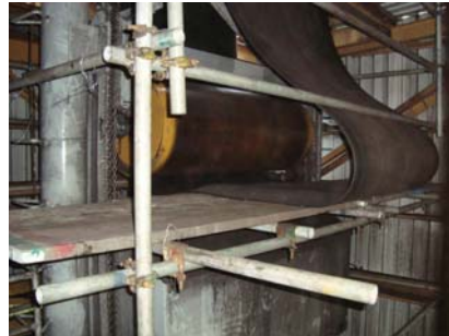
ตั้งนั่งร้านขึ้นพื้นที่จะทำงาน
