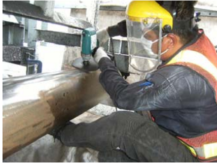
ขัดผิว ทำความสะอาดด้วยน้ำยา Trichloroethylene และ ทา Metal Primer PR 200 ให้ทั่วลูก Pulley
