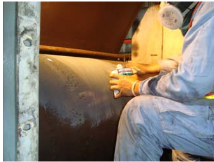
ล้างด้วย Trichloroethylene ทา Metal Primer PR 200 และทากาว Cement SC 2000 ที่ยางหุ้มและผิวPulley อย่างละ 2 รอบ
