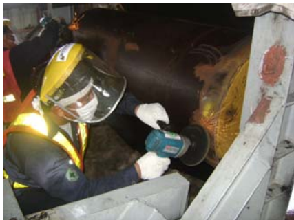
ขัดผิว ทำความสะอาดด้วยน้ำยา Trichloroethylene และ ทา Metal Primer PR
