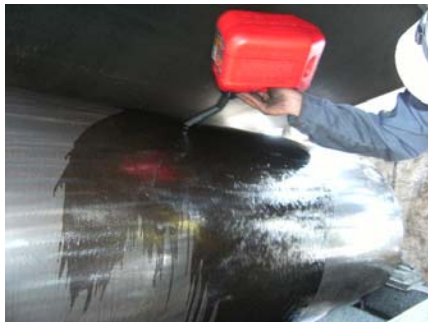
ขัดผิว ทำความสะอาดด้วยน้ำยา Trichloroethylene และ ทา Metal Primer PR 200 ให้ทั่วลูก Pulley
