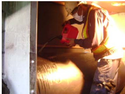
ขัดผิว ทำความสะอาดด้วยน้ำยา Trichloroethylene และ ทา Metal Primer PR 200 ให้ทั่วลูก Pulley
