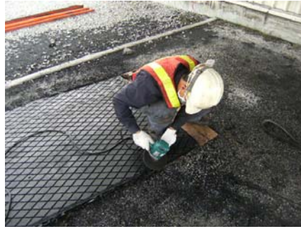
ขัดยางที่จะหุ้มของลูก Snub Pulley
