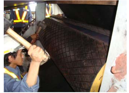
นำแผ่นยางมาหุ้ม Pulley และใช้ฉ้อนยางทุบไล่อากาศให้ทั่ว ชัดแต่งรอยต่อของยางให้เรียบร้อย
