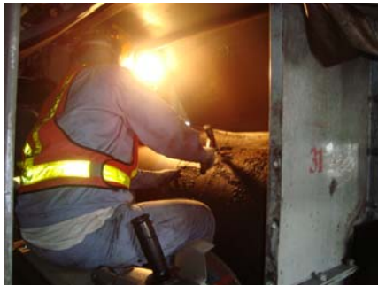
ใช้ฉนวนเคาะผิวเหล็กที่เป็นสนิมออกให้หมด ก่อนขัดผิวให้เรียบอีกครั้ง
