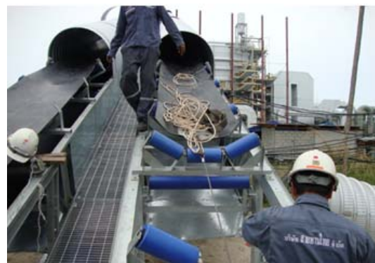
ติดตั้งลูกกลิ้ง HDPE ที่โรงไฟฟ้าใกล้ทะเล จังหวัดชุมพร
