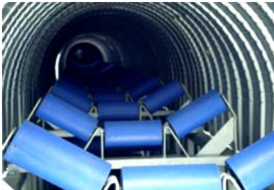
ติดตั้งลูกกลิ้ง HDPE ที่โรงไฟฟ้าใกล้ทะเล จังหวัดชุมพร
